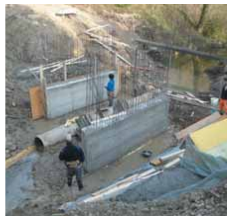
Das Widerlager der neuen Brücke.
