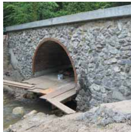
Die fast fertige Brücke.
