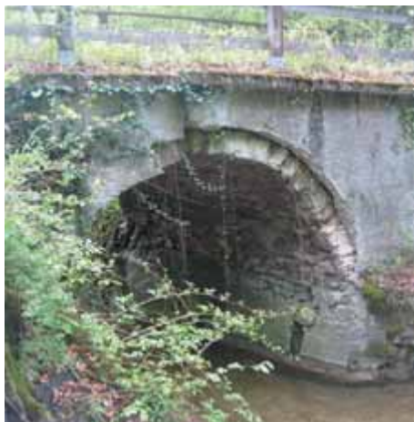
Die Brücke vor der Sanierung.
